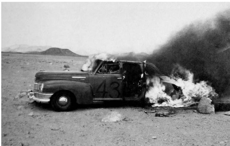
図-7.27 核爆発による熱線で車両装飾品が発火し、自動車火災へと拡大した。(ネバダ実験場にて)
