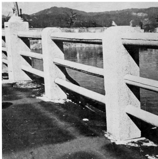
図-7.45 a 広島におけるアスファルト橋に熱線のため残された閃光の跡。手すりが熱線遮蔽物として作用しており、陰の長さと方向から爆発点が推定できる。
