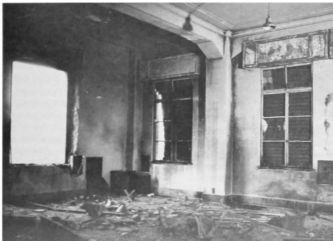
図-7.66 建物内の防火シャッターが爆風で吹き飛ばされた。中央のシャッターは恐らく建物を吹き抜けた爆風で吹き飛ばされた。（広島における爆心地から0.57マイル）
