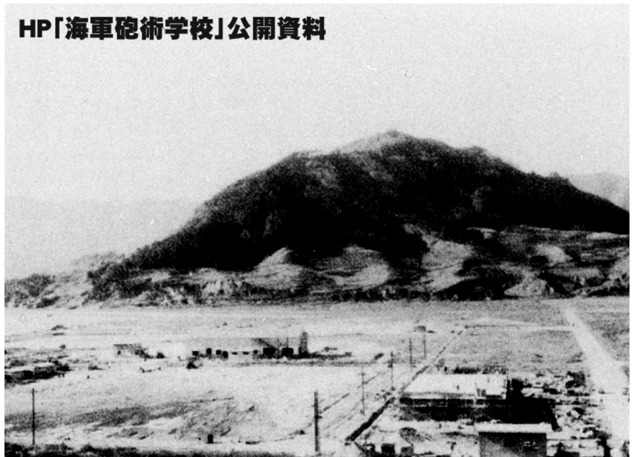
施設工事中の大原地区
