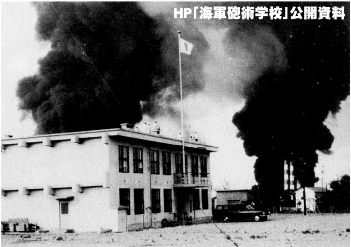
新潟基地分遣隊庁舎と炎上する石油タンク群
