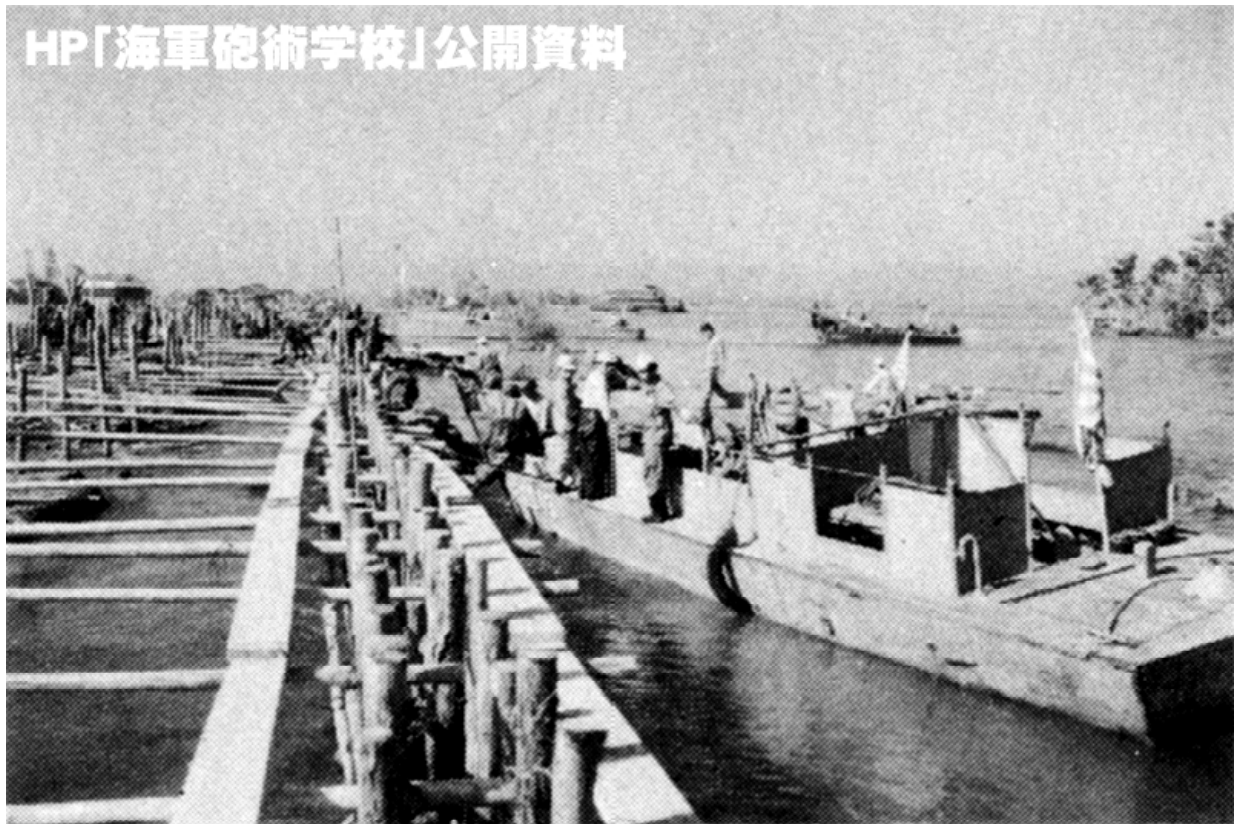
堤防復旧作業を支援する舟艇隊
