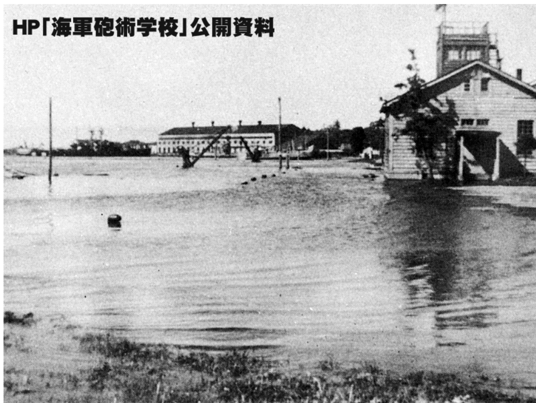
津波により冠水した大湊警備隊前岸壁（最高潮時）
