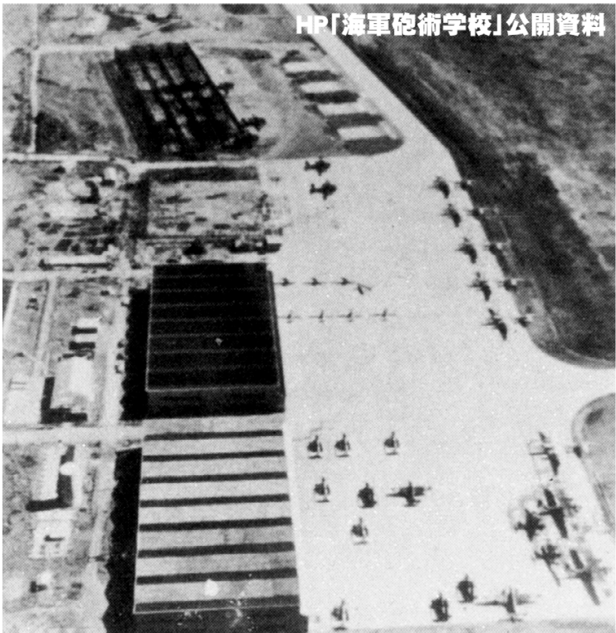
供与機が勢ぞろいした31年当時の鹿屋航空基地（手前は第1格納庫）
